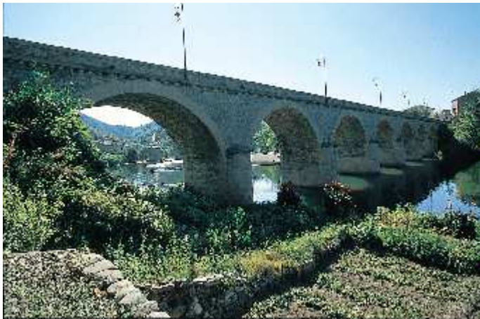
Le Pont de Roquebrun
