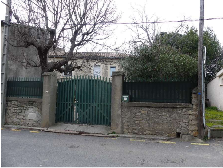
Ramonétage, 3 route de La Caunette.
