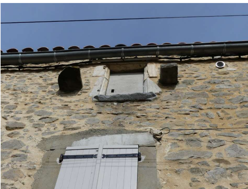
Maison 1 rue de la Tramontane, détail de la baie fenière.
