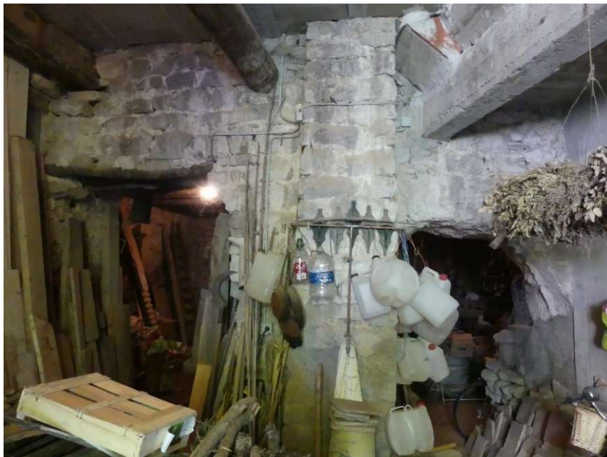
Percements de la muraille de part et d'autre d'un contrefort.
