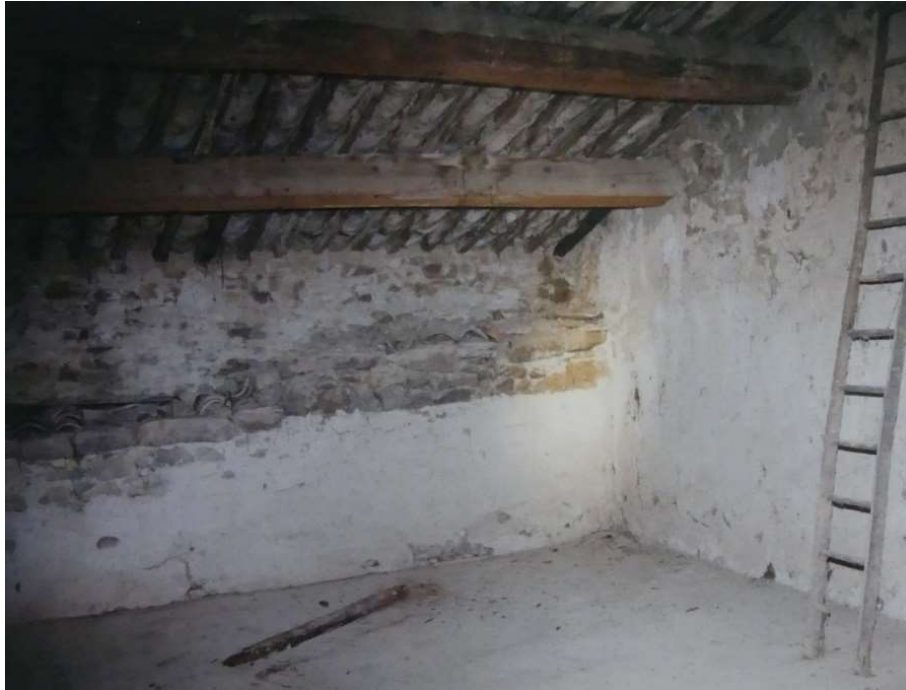
Maison 34 rue Saint-Martin, étage de comble, vestiges de l'enceinte, photos Pia Everson.
