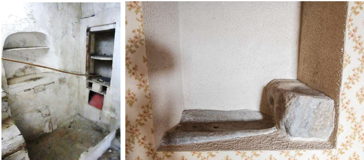
Maison 6 place de l'Eglise, placard et potager de cuisson / Maison 4 rue Saint-Martin, évier et rebord en pierre usé par le frottement de la cruche, ©Amélie Boyer, Inventaire général Région Occitanie, 2021.
