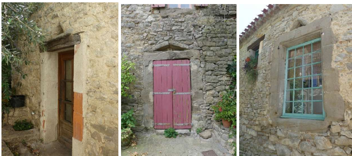
Triangles de décharge : Maison 5 place de l'Eglise / Maison 8 place de l'Eglise / Maison 8 rue Saint-Martin.
