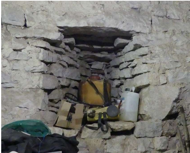
Elévation intramuros , archère (parcelle A137).
