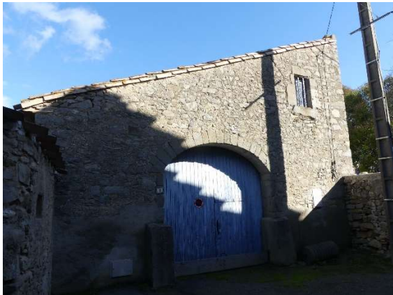
Chai avec porte charretière à arc surbaissé clavé, rue de la Source / chai avec porte charretière surmontée d'un linteau en bois, rue d'Occitanie.
