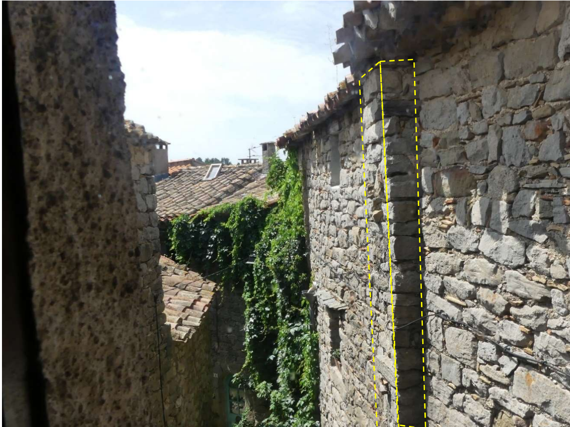
Exemples de têtes de mur repérées dans le bâti villageois.
