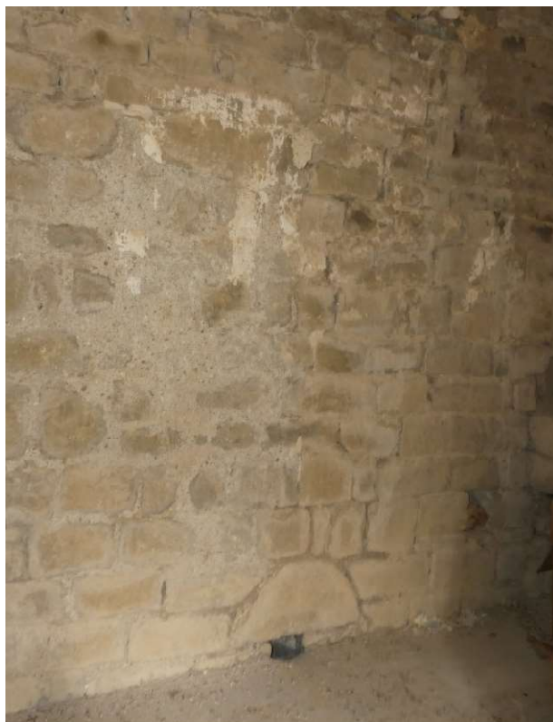
Mur gouttereau sud de la nef, vue intérieure du clocher.
