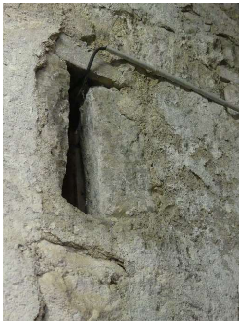
Elévation extramuros , archère (parcelle A 135).
