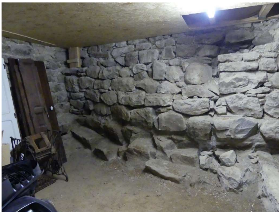
18 rue des Fossés, mur de soutènement et banc de grès.
