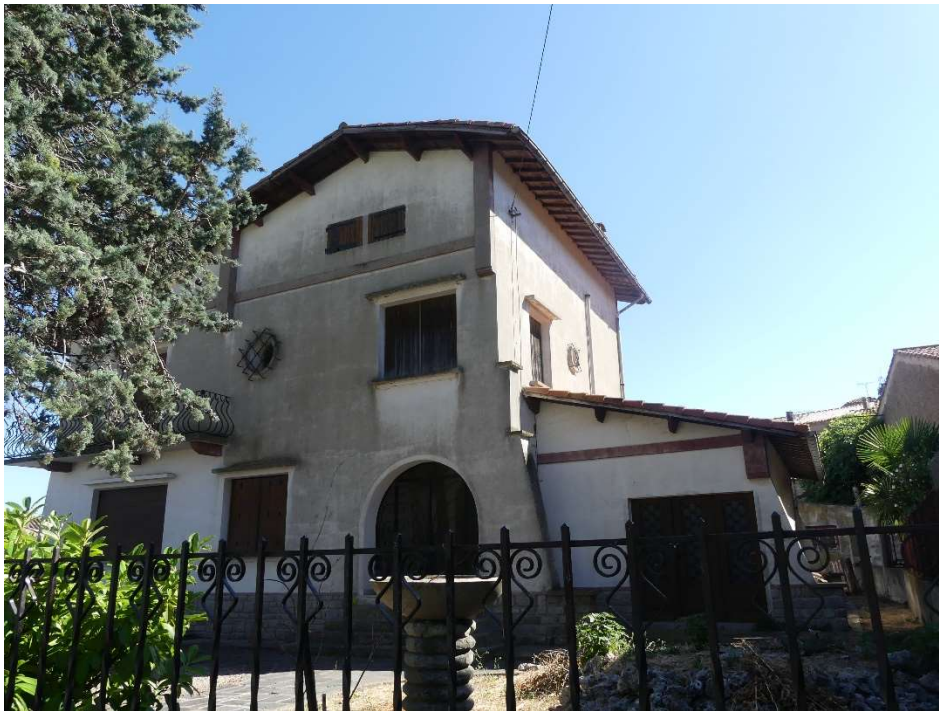
Pavillon des années 1970, 18 rue du Minervois.
