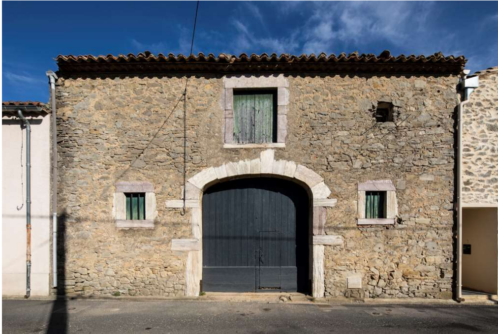
Maison 5 route de La Caunette, chai avec encadrements en marbre.
