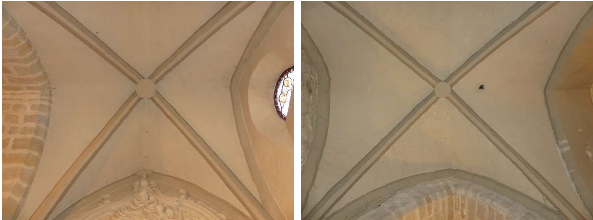
Eglise Saint-Martin d'Aigne, bas-côté sud, voûtes d'ogives.
