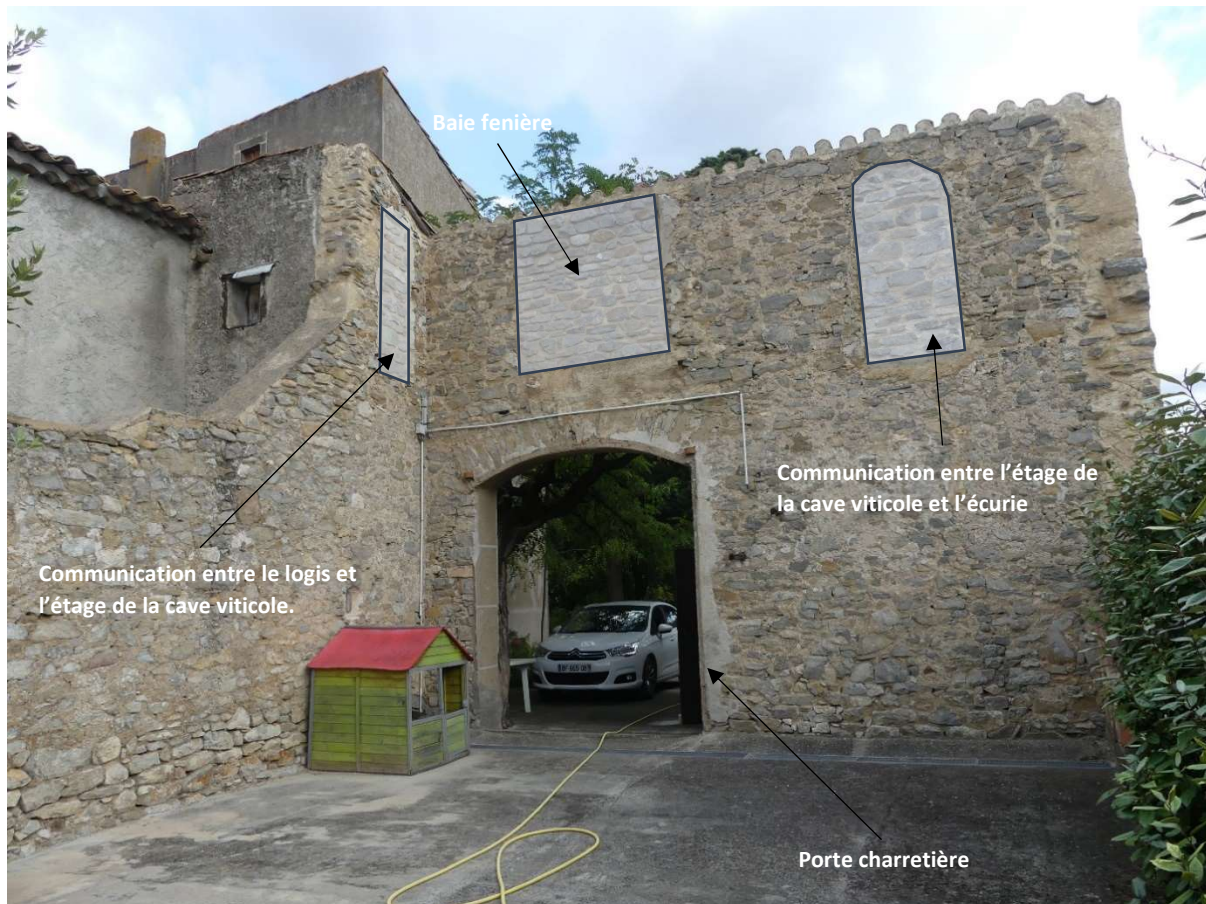
Maison 14 rue des Fossés : Vue intérieure du chai, qui s'est écroulé il y a quelques années, permettant de rendre compte des anciennes communications entre les trois corps de bâtiment.
