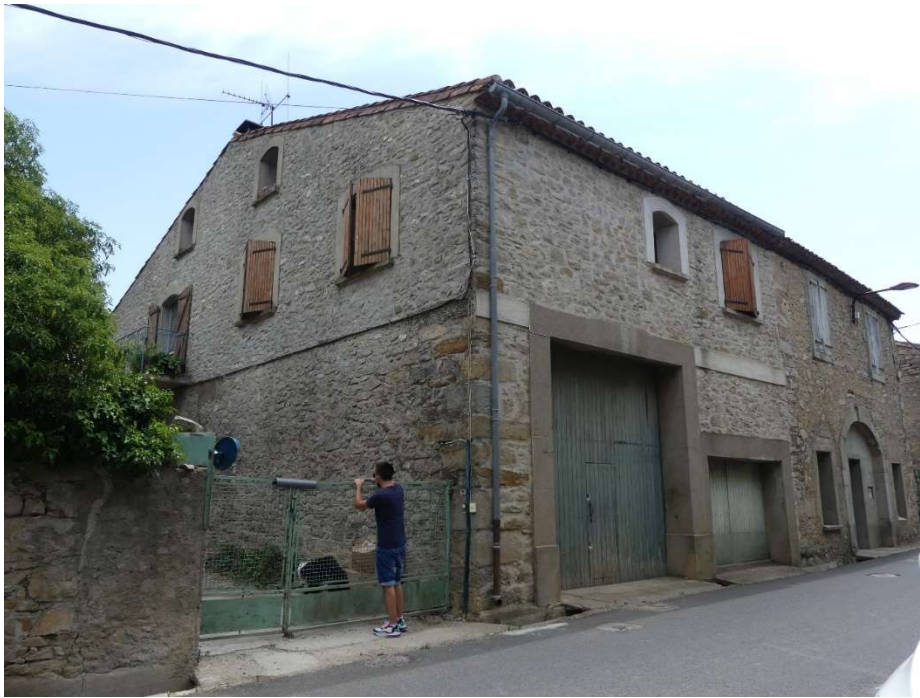
Maison bloc en hauteur : la partie agricole est en rez-de-chaussée, le logis à l'étage se développe sur le mur pignon. L'accès au logis se fait depuis l'élévation postérieure.
