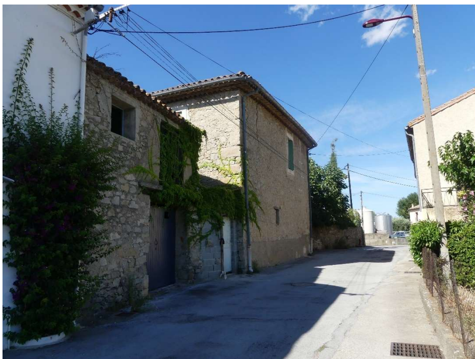
Maison 4 rue des Jardins : élévations latérales et postérieures. Le bâtiment à gauche servait d'écurie et de fenil.
