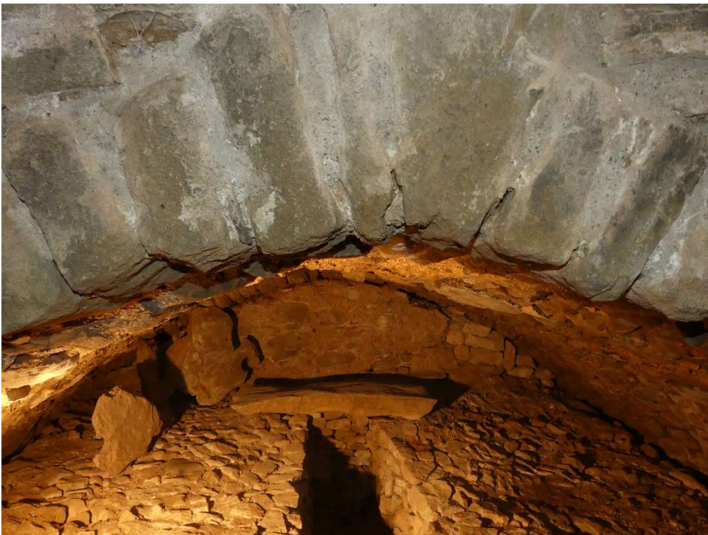
Arche du pont enjambant les anciens fossés, 2021.
