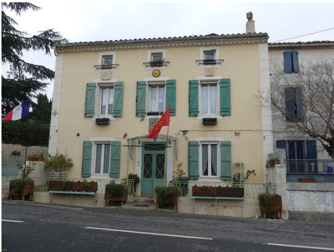
Maison 8 rue des Ecoles.
