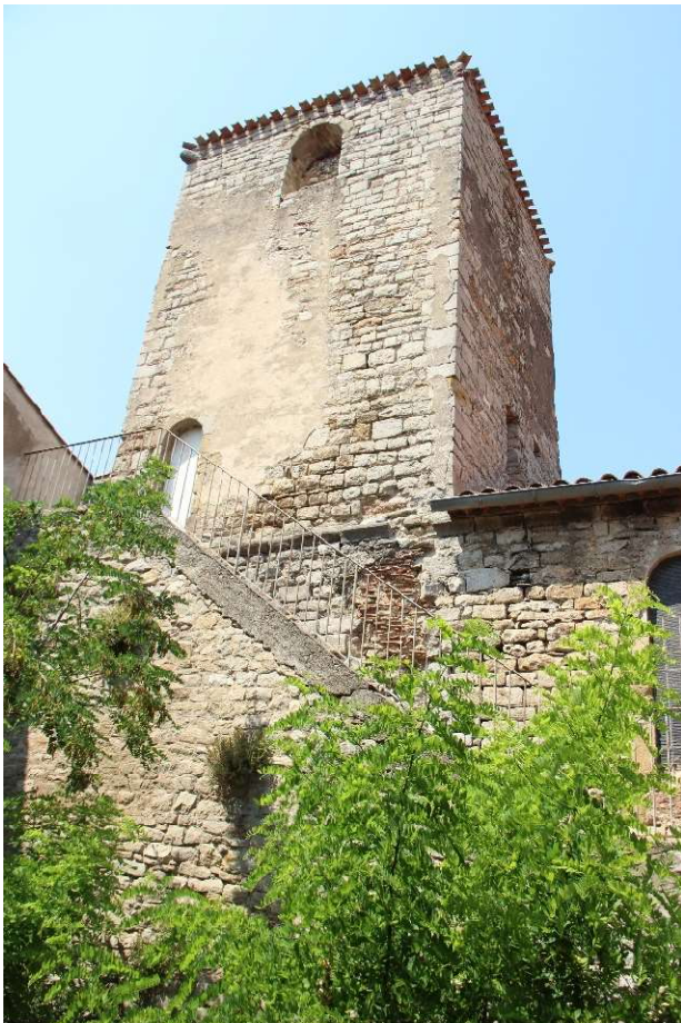
Eglise Saint-Martin, mur du bas-côté sud et clocher.
