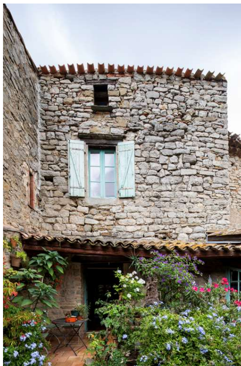
Mur d'enceinte rue des Fossés ayant conservé une partie de son appareil médiéval, ©Amélie Boyer, Inventaire général Région Occitanie, 2021.
