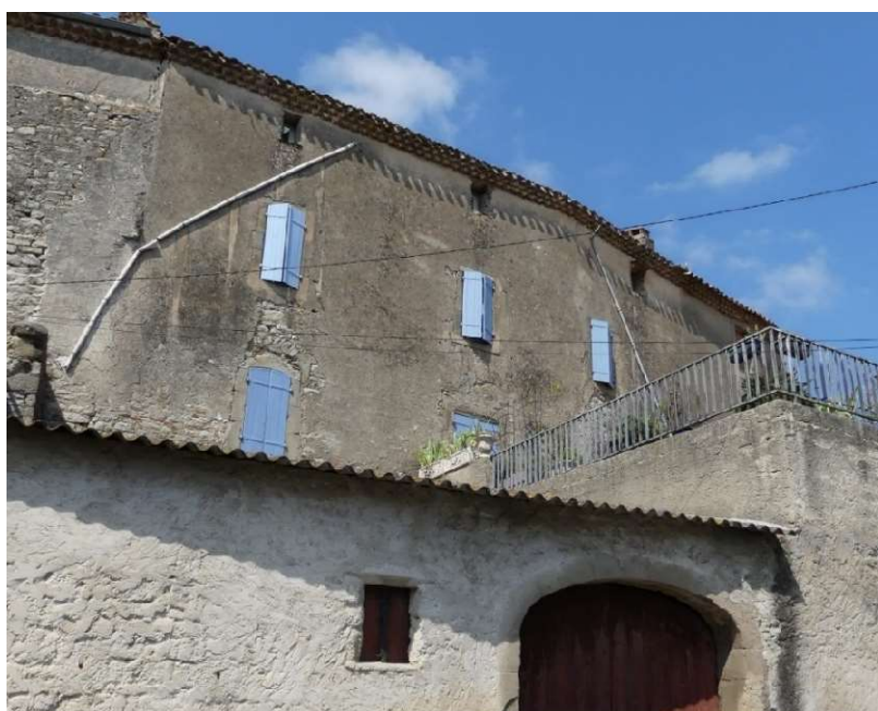
Mur d'enceinte modifié au XVIII e siècle.
