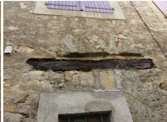
Entrées de bâtiments agricoles, linteaux en bois surmontés de lauzes de schistes : 8 place de l'Eglise / 1 rue Saint-Martin / 10 rue Saint-Martin.
