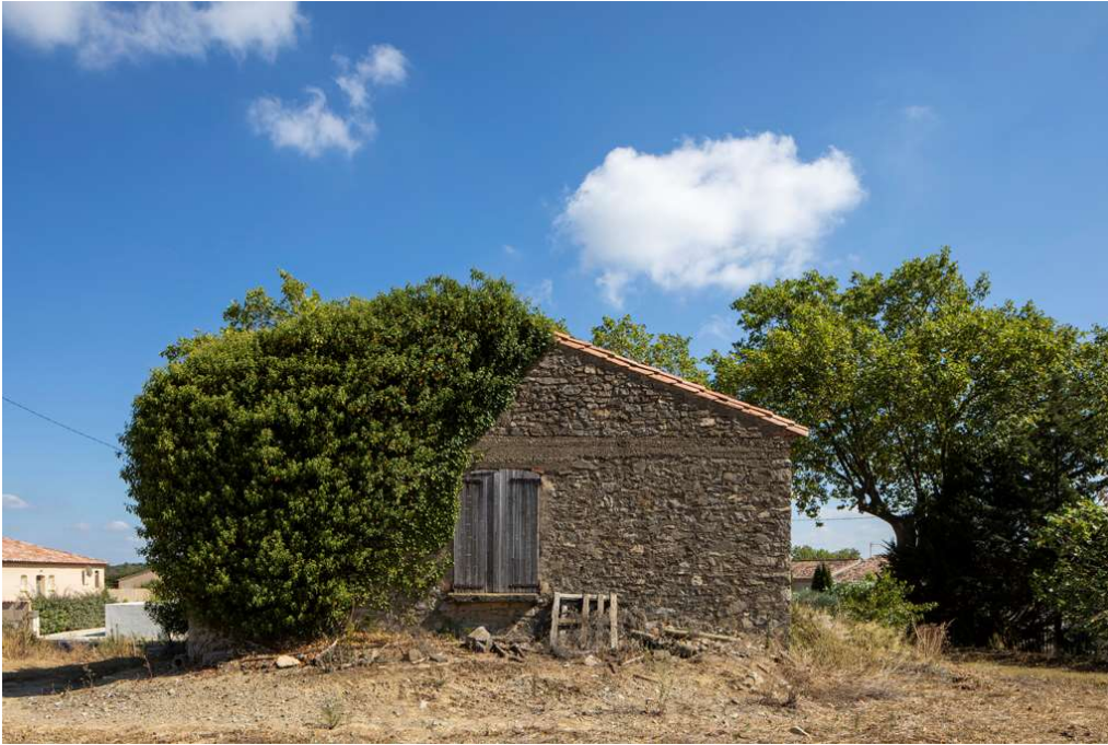
Chai isolé, route de La Caunette, quai de déchargement sur la façade postérieure. ©Amélie Boyer, Inventaire général Région Occitanie, 2021.
