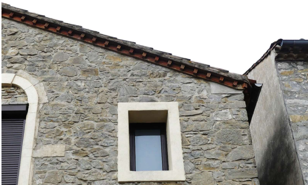
Maison 4 rue des Ecoles, détail de la corniche en brique creuse.
