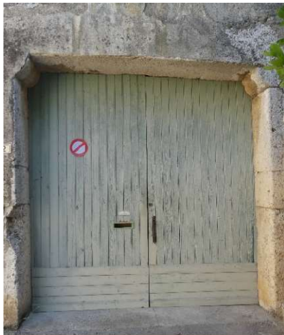
Maison 2 rue des Jardins : porte charretière en tuf avec linteau sur coussinets / Chai route de La Caunette, linteau de la porte charretière en poutre métallique.
