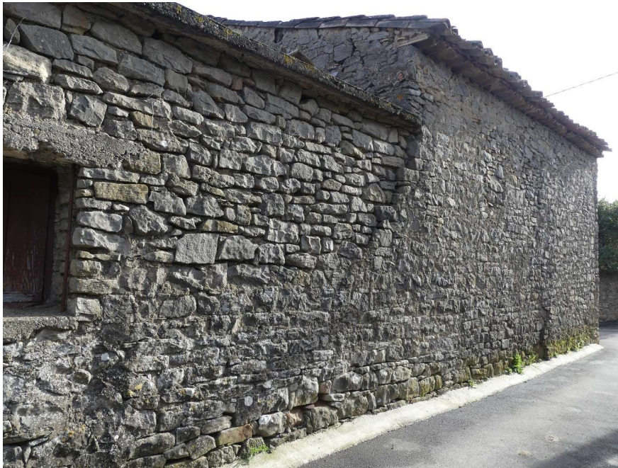
Moulin à huile, actuellement remise agricole, élévation ouest.
