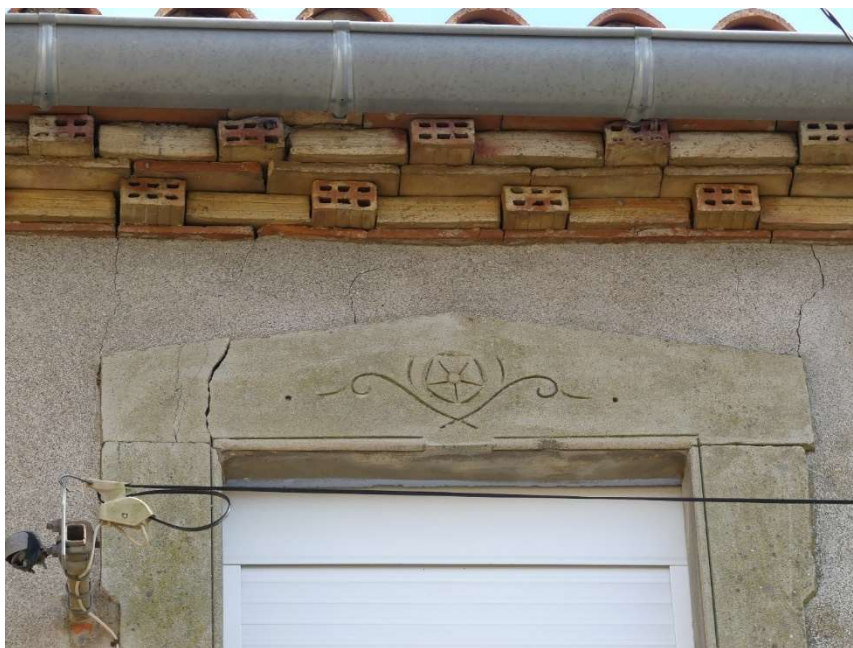
Maison 12 route de La Caunette, détail de la corniche en brique creuse.
