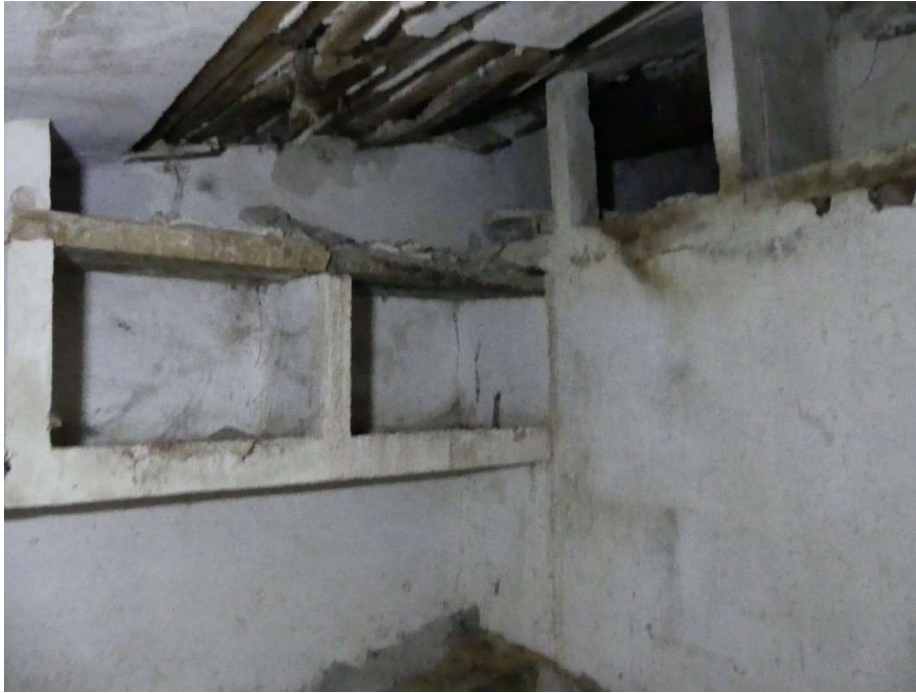
Maison 16 rue Saint-Martin, aménagement intérieur du pigeonnier.
