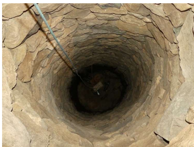
Puits situé au rez-de-chaussée d'une maison place de l'Eglise.
