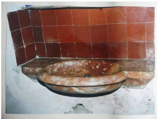
Maison 34 rue Saint-Martin, décor avant travaux (photographies Pia Everson)
