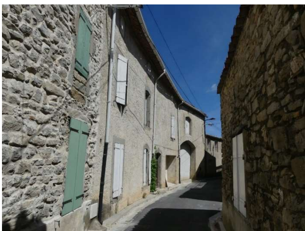
Maison de la fin du XVIII e siècle de type bloc à terre construite dans les faubourgs.
