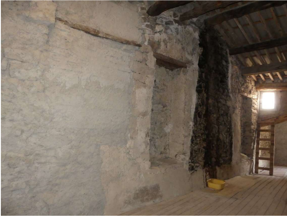
Portes de communication inter combles murées.
