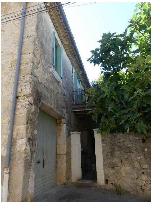
Maison 4 rue des Jardins : élévation principale, chai et cellier au rez-de-chaussée, logis à l'étage accessible par un escalier extérieur.
