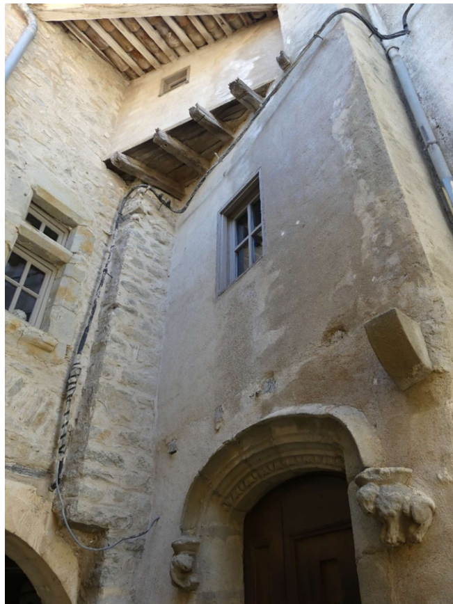
40 rue Saint-Martin, structure en encorbellement au 2 e étage, solives sciées et corbeau au 1 er étage.
