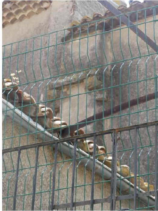
Structure en encorbellement contre le mur d'enceinte (parcelle A133).
