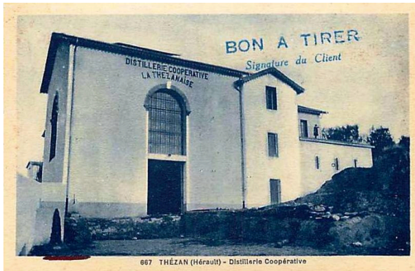
Distillerie Coopérative de Thézan-lès-Béziers
