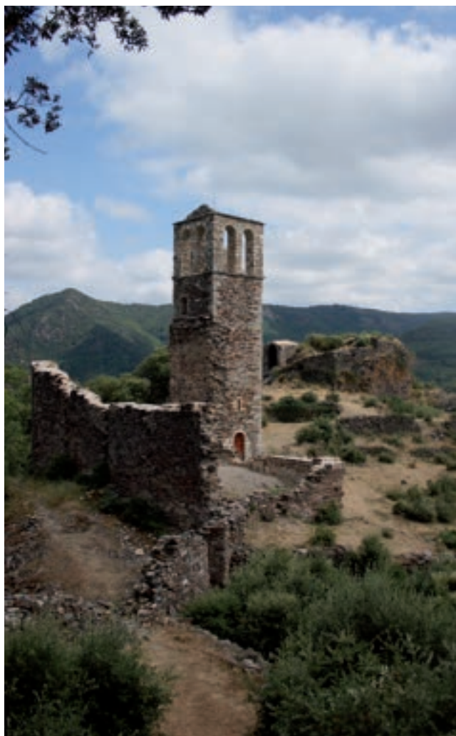
VUE PARTIELLE DE L'HABITAT CASTRAL TARDIF DE NEYRAN, FRONT NORD-EST AVEC FAÇADE À CONTREFORT
