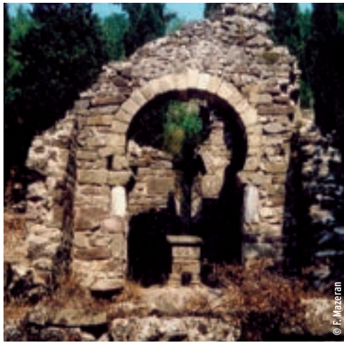
CHAPELLE SAINT-GEORGES À LUNAS L'arc outrepassé repose sur des fûts de colonnes et des chapiteaux de marbre antiques en remploi.
