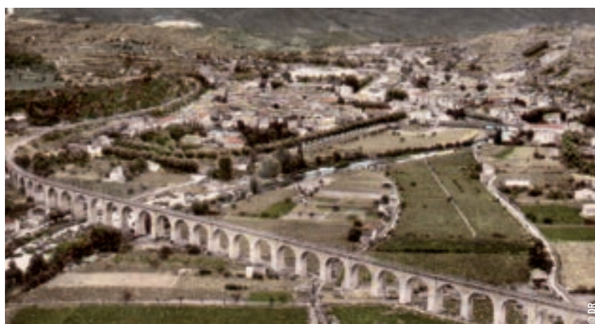
LE GRAND VIADUC DE BÉDARIEUX DANS LES ANNÉES 1950, ALORS QU'IL LIVRAIT PASSAGE À L'EMBRANCHEMENT PÉCHINEY (BAUXITES) DONT LES INSTALLATIONS SONT VISIBLES SUR LA GAUCHE
