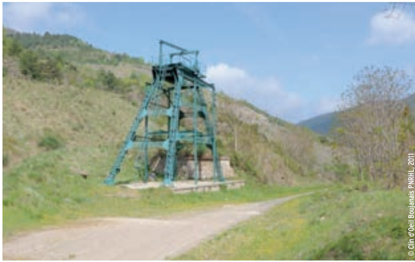
CHEVALEMENT MÉTALLIQUE DU Puits DURAND, À CAMPLONG
