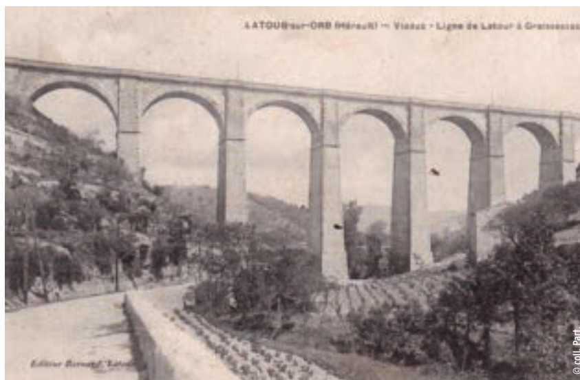
LE VIADUC DE BOUSSAGUES, ENTRE LA TOUR-SUR-ORB ET GRAISSESSAC.
