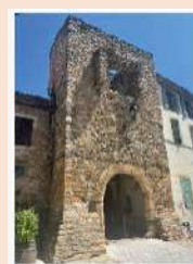
Sécurisation et restauration de la tour porte et du passage de la Carambelle
