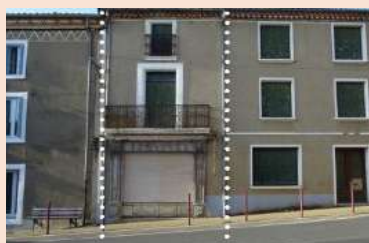
Déplacement et réhabilitation du multiservices communal
