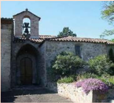
Confortement et gros entretien de l'église Saint-Saturnin de Clairac
