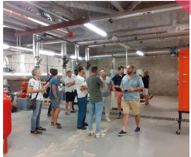
» Visite technique de la chaufferie de l'Hôpital de Perpignan / rencontres régionales CEP juin 2025 © Pays
